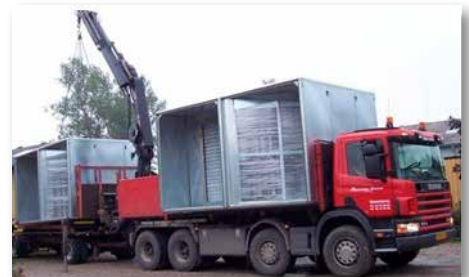
Dubbel korsvärmeväxlare för aggregat på 80 000 m 3 /h
