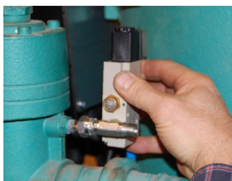
Montera magnetventil för sandventil
