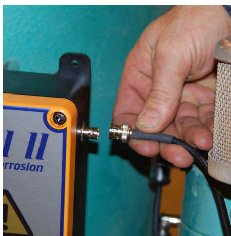
Montera förlängningskabeln på mottagaren
