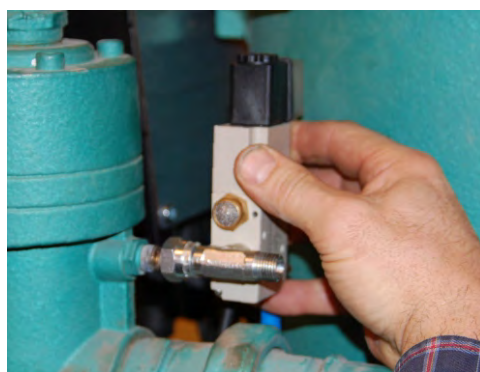
Montera magnetventil för sandventil
