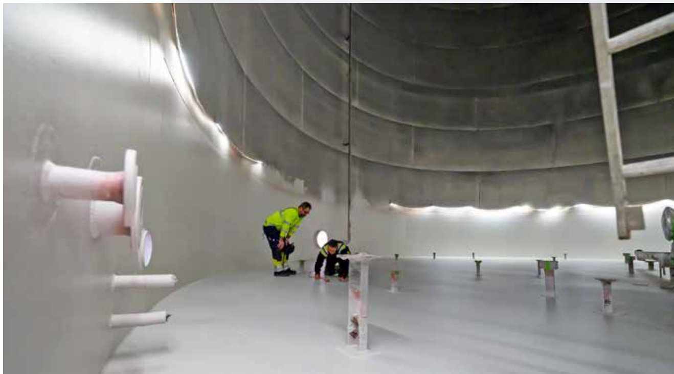
Mätning av tjockleken på färgen i cisternen.
