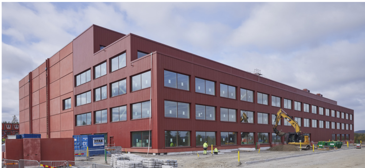
Det nya riksarkivet är onekligen en imponerande byggnad.
