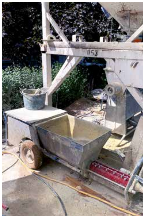
För fasadarbetena använder Fasadentreprenad AB maskiner från Anti-Corrosion. Man har en frekvensstyrd skrupvpump Cura 3900 och en genomströmningsblandare Maltech M25L.
