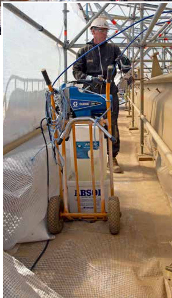
Graco 395 användes för applicering av klotter-skyddet på bron.
