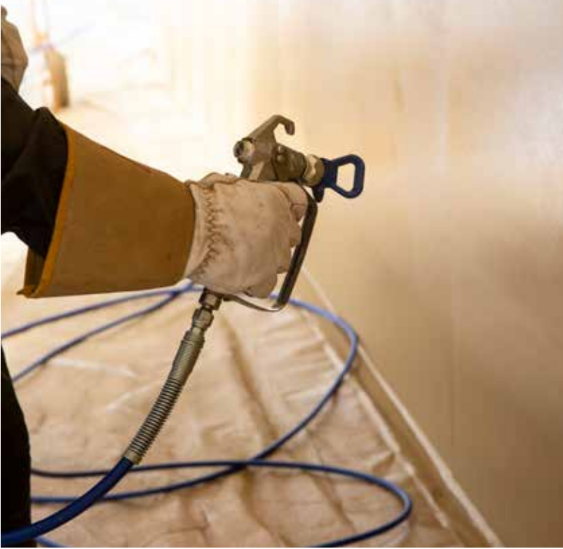
Med Graco 395 gick det snabbt att applicera klotterskyddet på bron.
