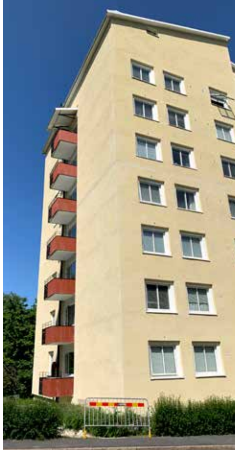
Snyggt och fräscht efter fasadrenoveringen.
