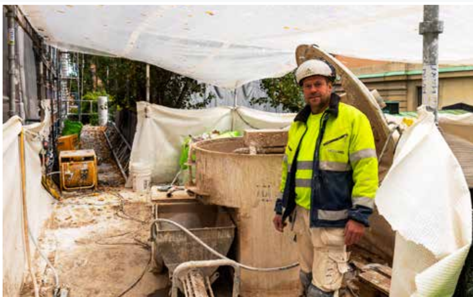
Jan Tanskanen, Puts & Tegel, vid en av Cura-pumparna som använts flitigt vid restaureringen av Storkyrkan.
