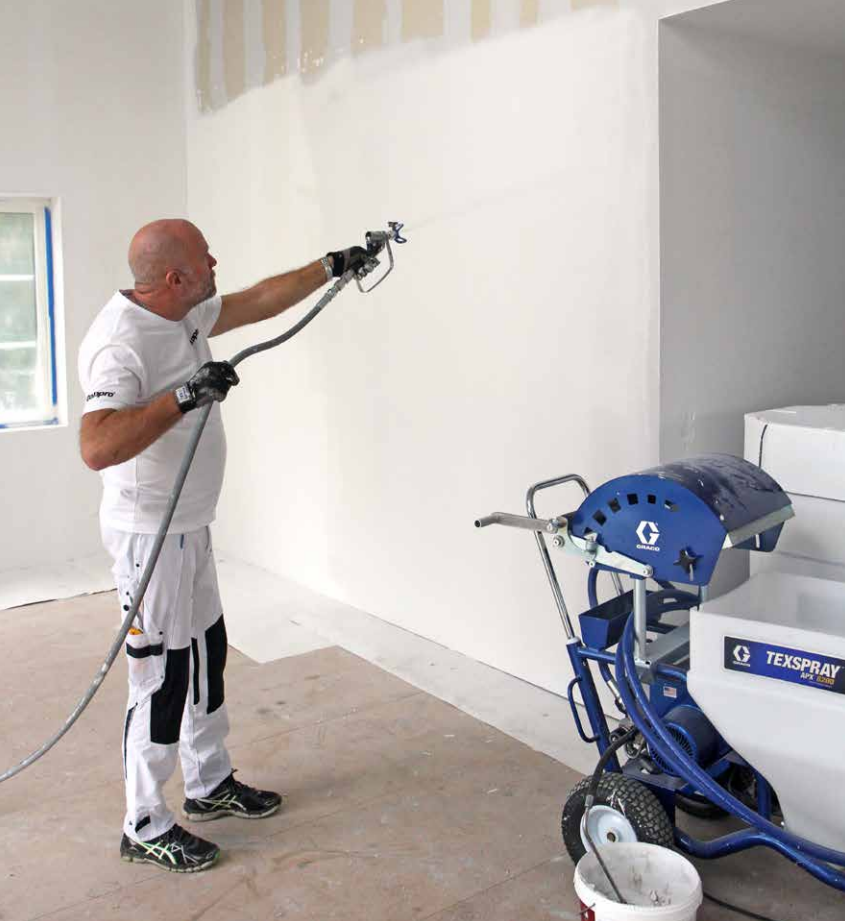
Sprutapplikering av släpljusvägg med Graco APX 8200.
