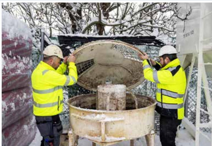
Peter Jonsson och Jimmy Åkesson från Anti-Corrosion på plats och utför service på Målarkalks maskiner.
