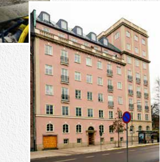
Fasaden på Strandvägen 65, ett av Kumla Fasadteams många prestigeprojekt.
